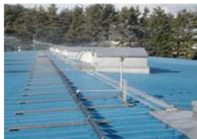
循環式屋根散水装置の運転状況
